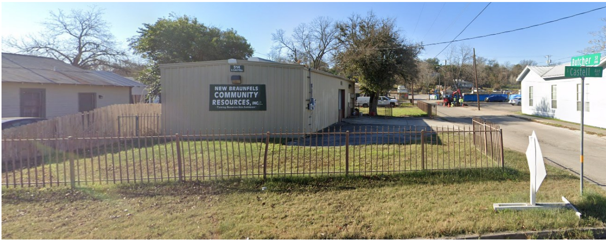
514 S Castell Ave— Castell Frontage
