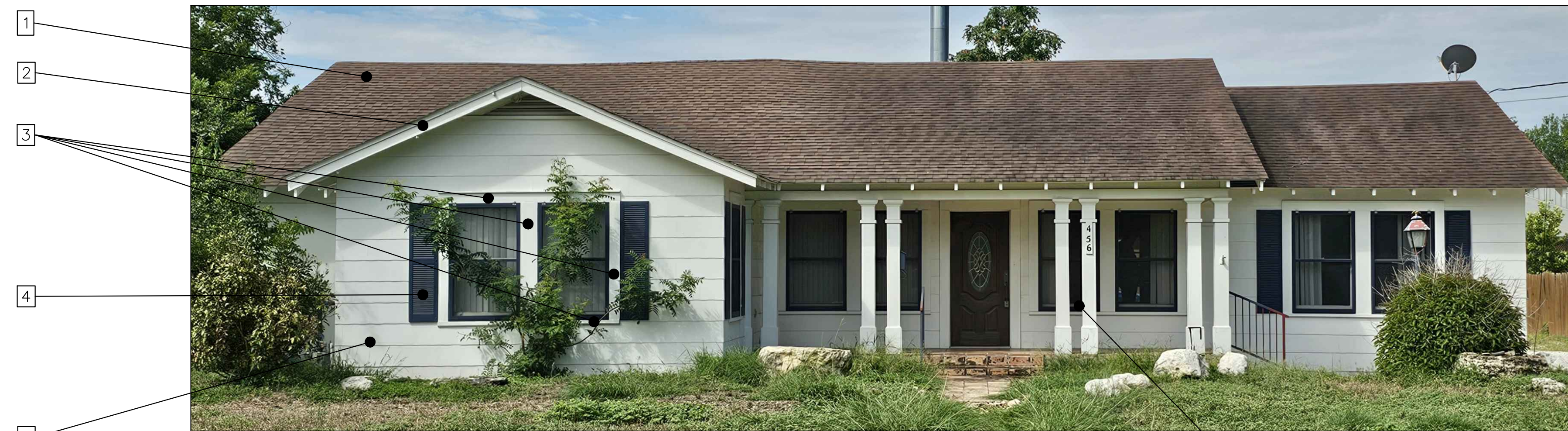
EXISTING FRONT EXTERIOR SCALE: N.T.S.
